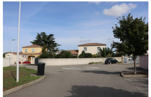
Lotissement Arc-en-Ciel murs pleins
