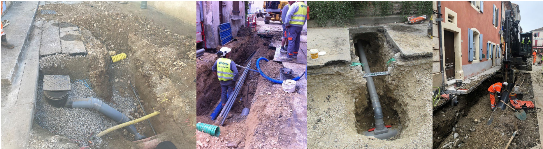
Travaux des réseaux humides des rues Villeneuve, Fourouze et Mazet / Chabeuil 2023
